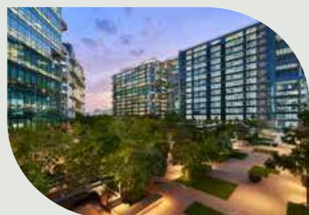
Gera Commerzone Kharadi, Pune
